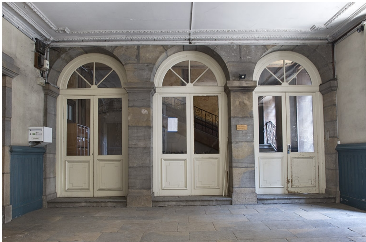
Vue de l'entrée de l'escalier, de face.
