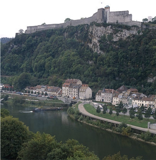
Vue d'ensemble plongeante sur l'extrémité amont.
