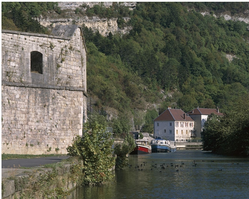
Vue d'ensemble, depuis l'amont.
