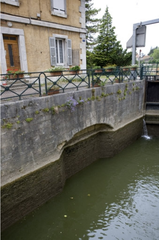
Emplacement de l'ancien vantail amont, dans le bajoyer droit.
