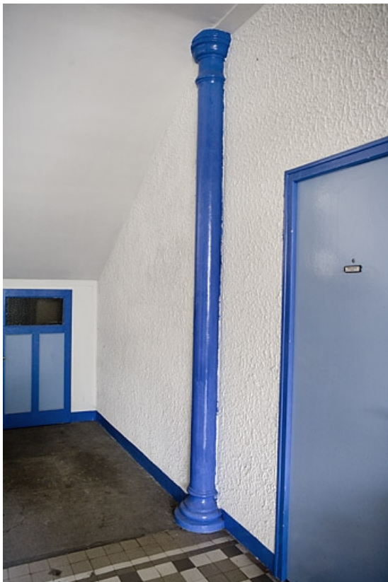
Intérieur de l'entrée : poteau en fonte.
