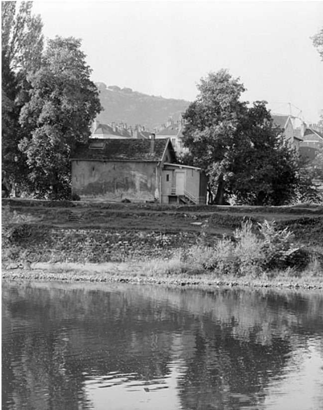
Façade antérieure en 2003, avant restauration.
