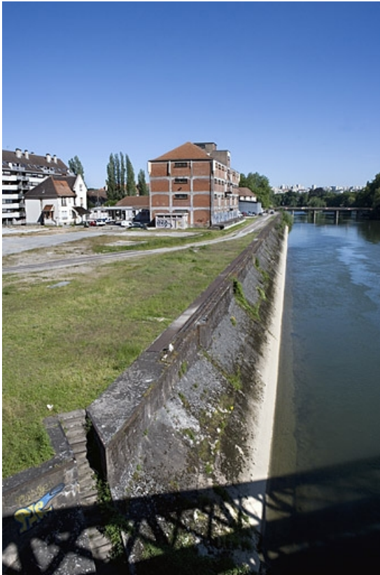
Entrepôt et quai, depuis l'amont.
