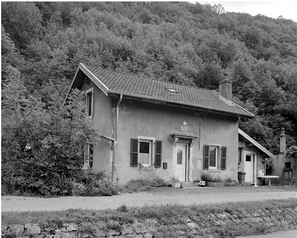
La maison d'éclusier, depuis l'écluse.
