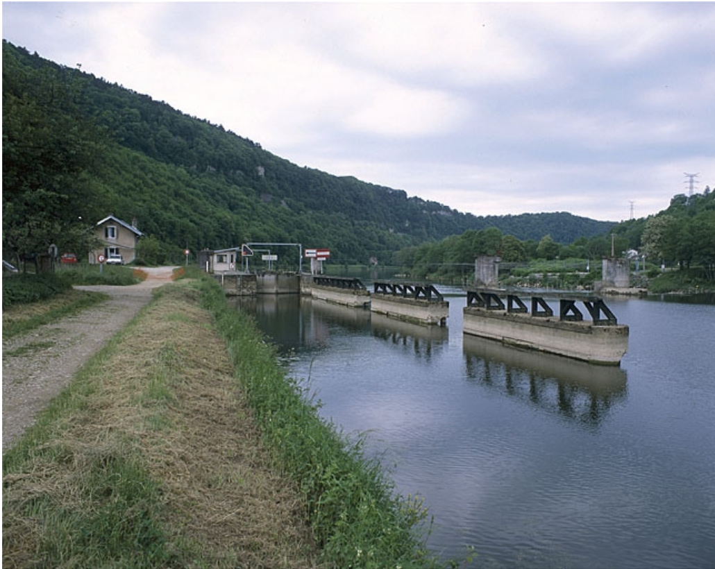
Vue d'ensemble depuis l'amont.
