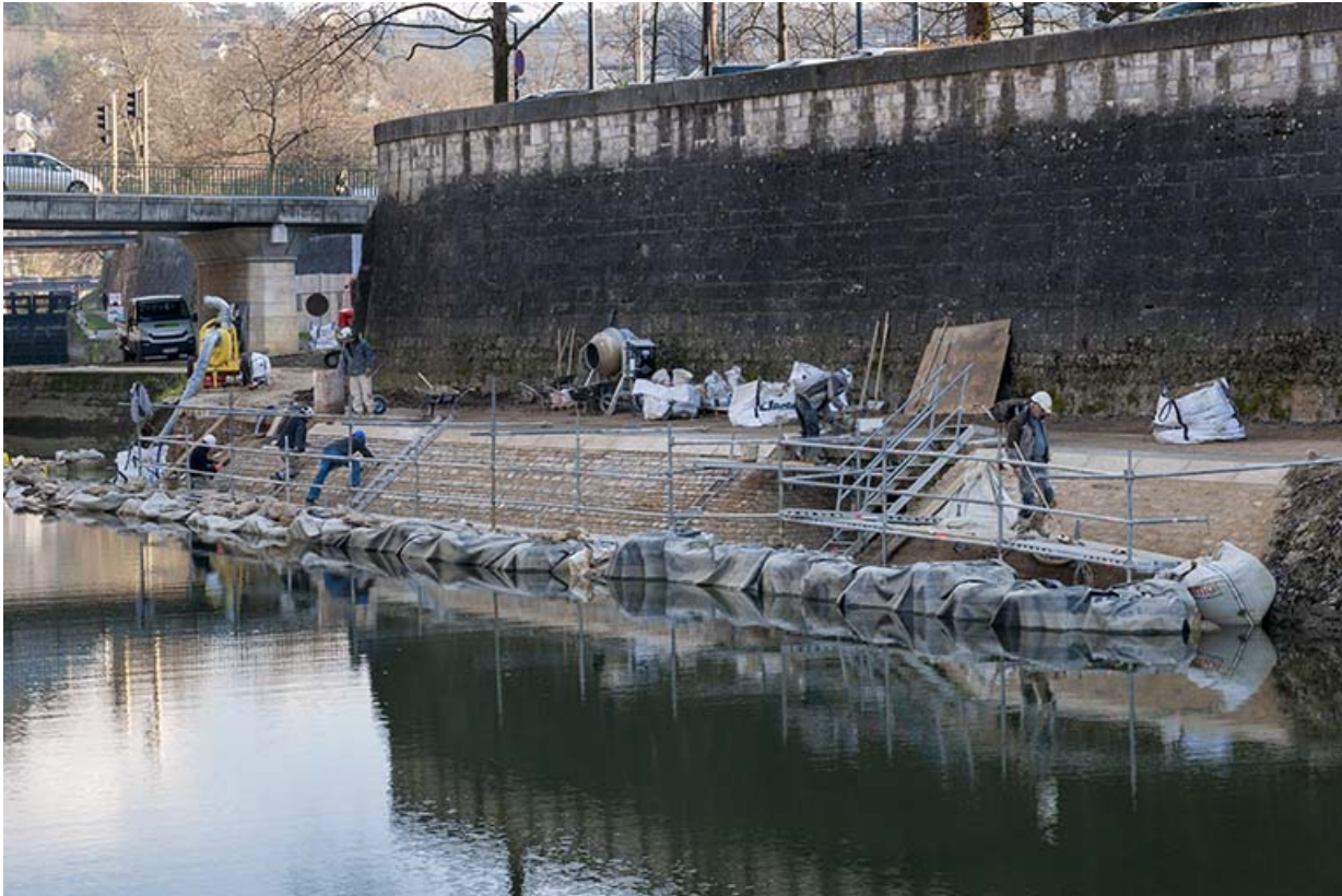
Réfection du perré du chemin de halage en aval du moulin Saint-Paul : vue d'ensemble depuis l'aval. 25, Besançon
