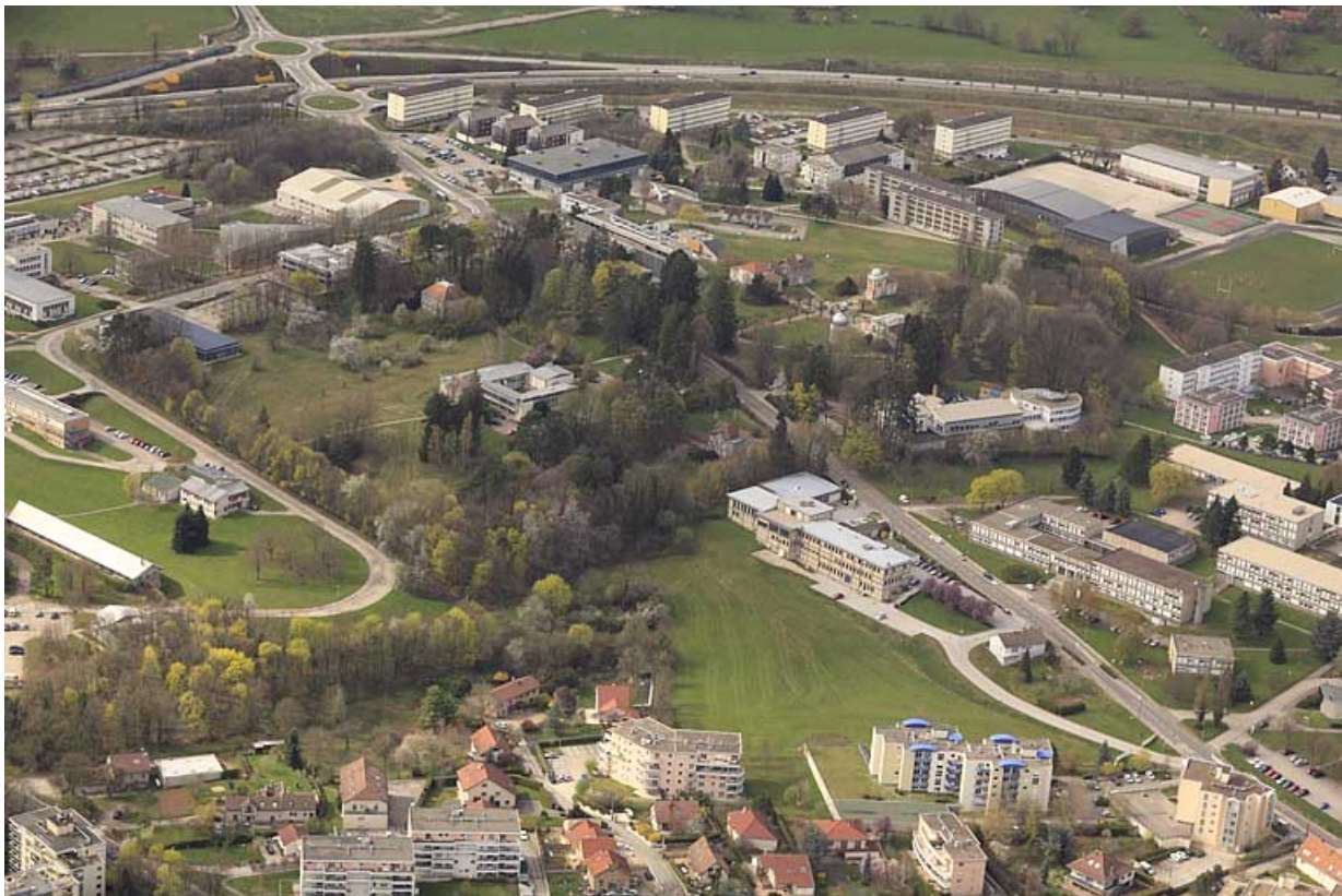
Vue aérienne du site, depuis le sud-est.
