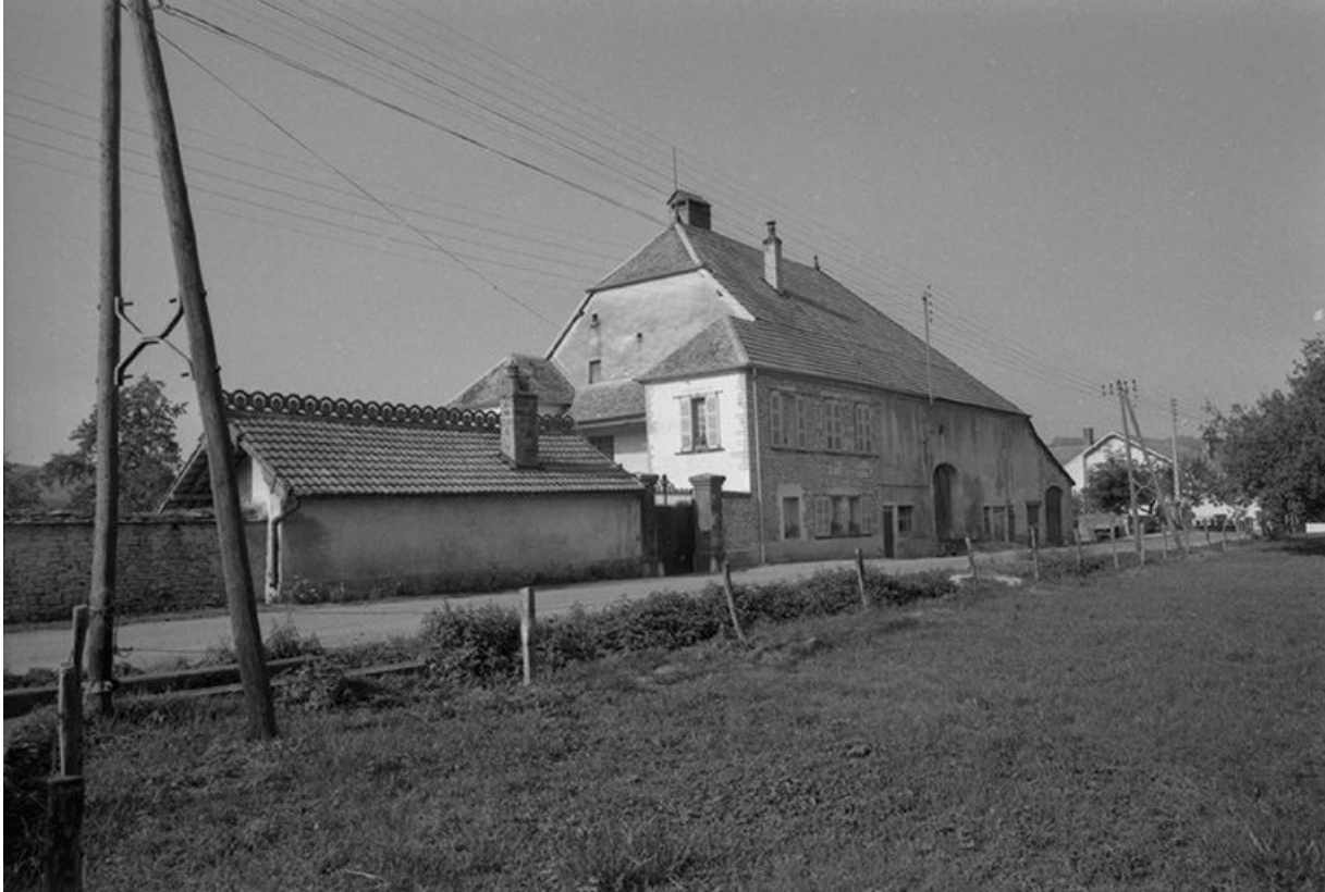
Vue d'ensemble depuis la rue.
