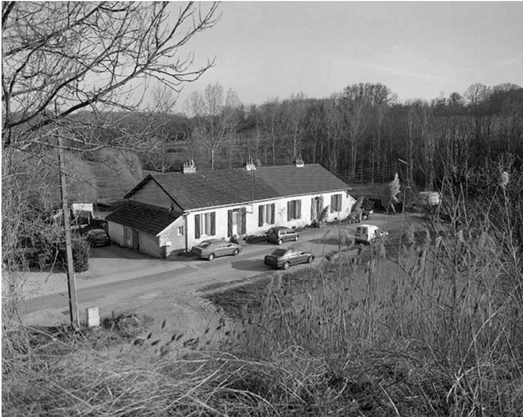
Logement d'ouvriers (19 rue des Saulniers).
