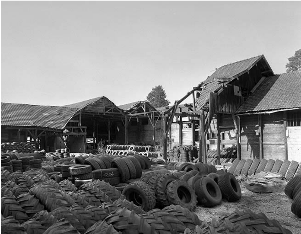
Magasins industriels depuis le nord.
