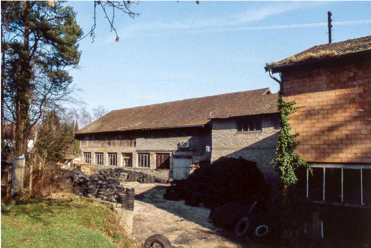
Façades occidentales des magasins industriels.
