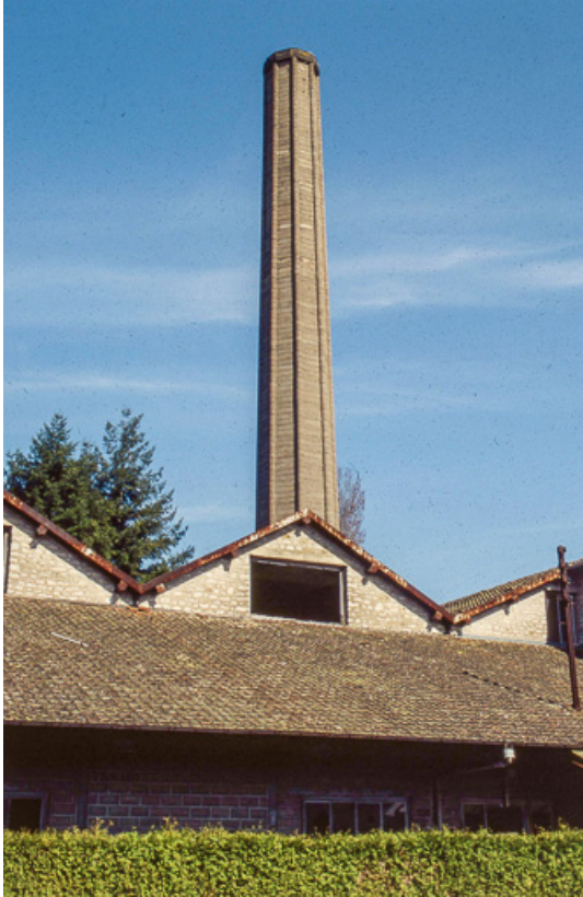
Quai couvert, magasins industriels et cheminée.
