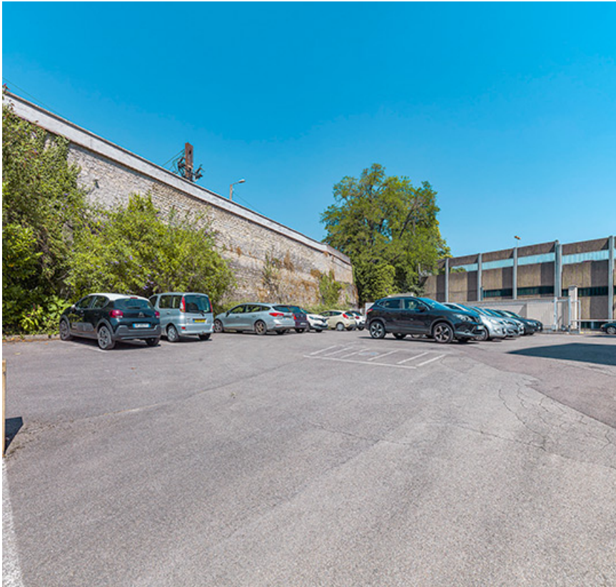
Elévation du rempart de la Miséricorde.
