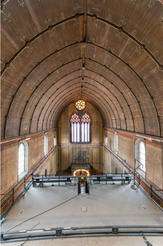
Nef : charpente lambrissée en berceau brisé, depuis la croisée du transept. Le toit de la salle de spectacle occupe le 1er plan. 21, Dijon, 15 rue Danton
