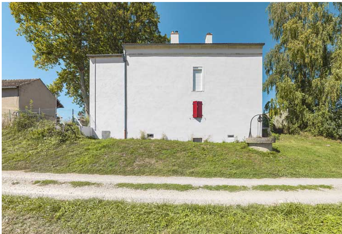
La maison éclusière : face arrière.
