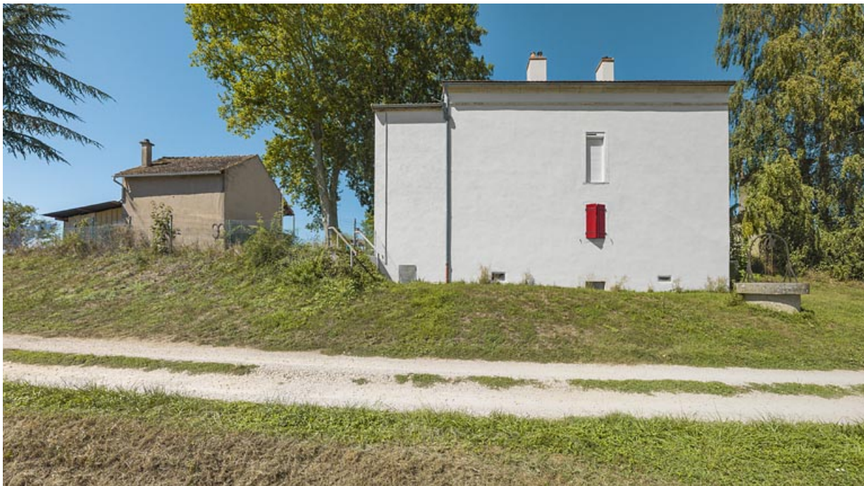
La maison éclusière : face arrière.
