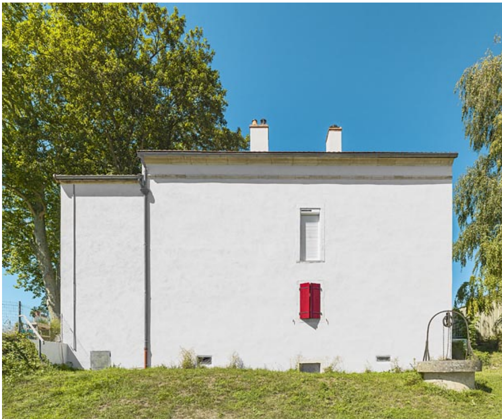
La maison éclusière : face arrière.
