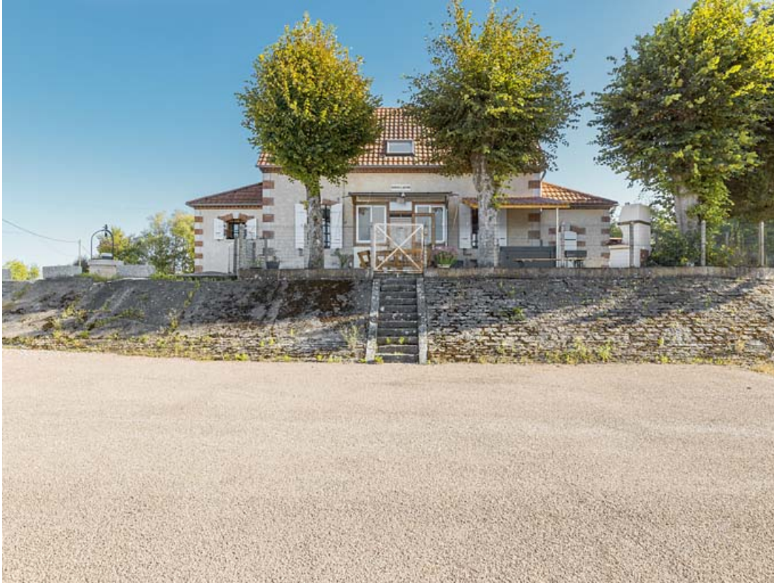
Vue d'ensemble de la maison du barragiste.
