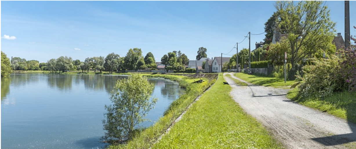
Vue d'ensemble de la digue, prise d'aval.
