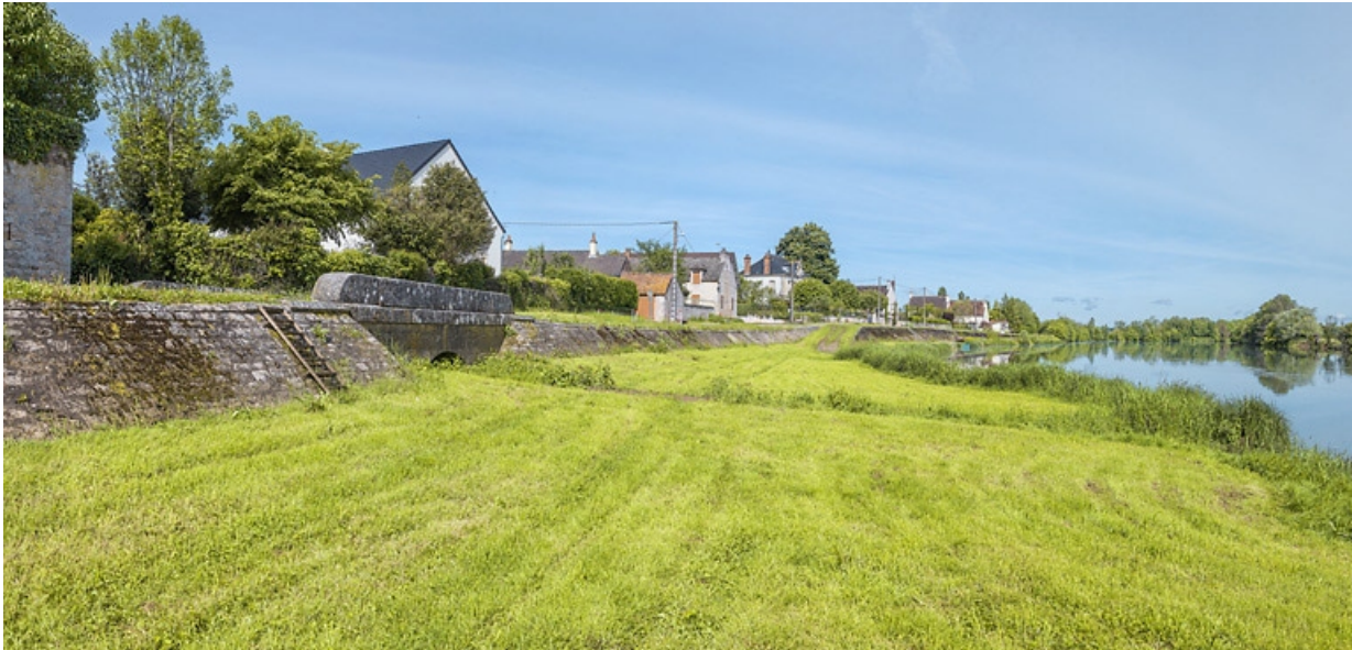
Ponceau au milieu de la digue.
