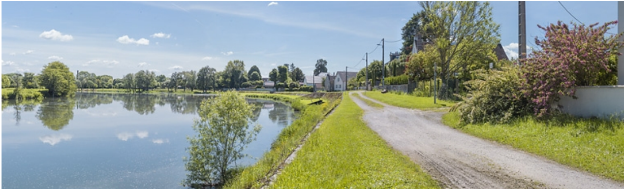
Vue d'ensemble de la digue, prise d'aval.
