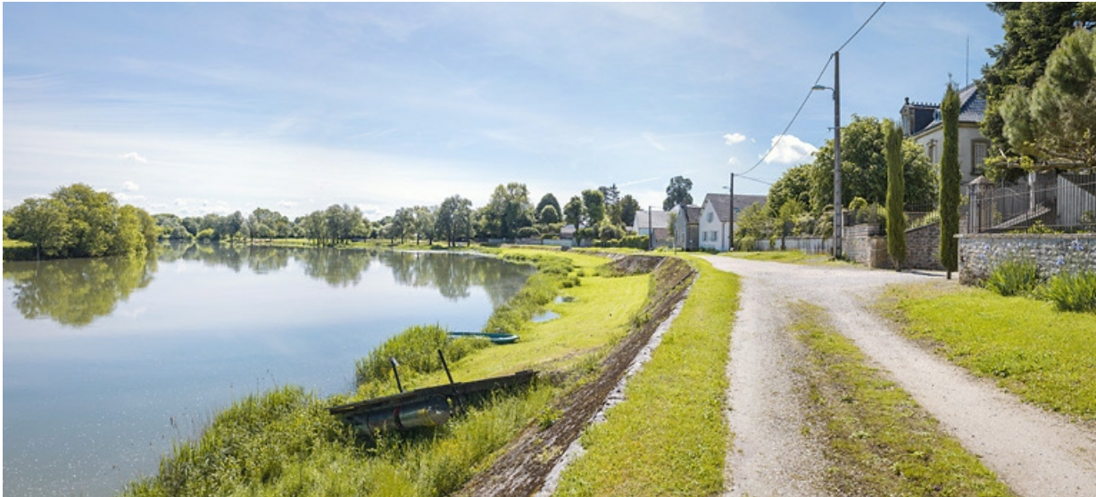
Vue d'ensemble de la digue, prise d'aval.
