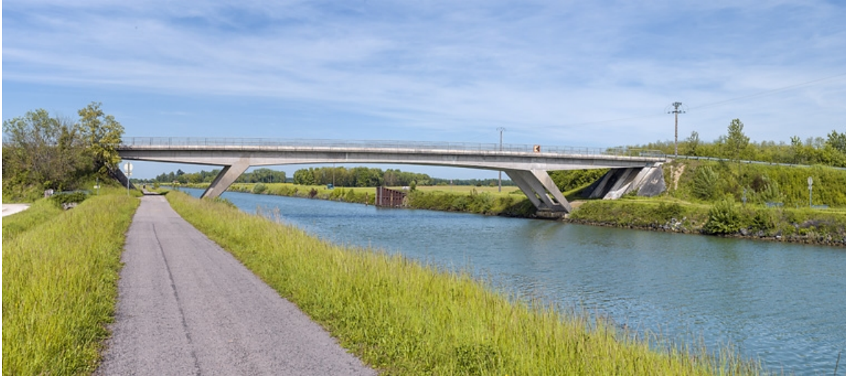
Vue d'ensemble d'amont, rive gauche.
