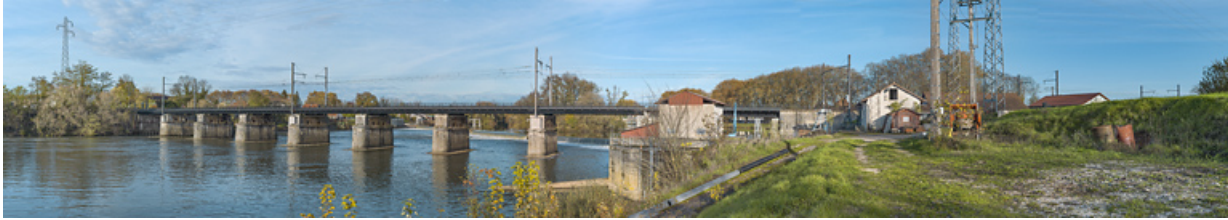
Le pont ferroviaire d'Auxonne (21).
