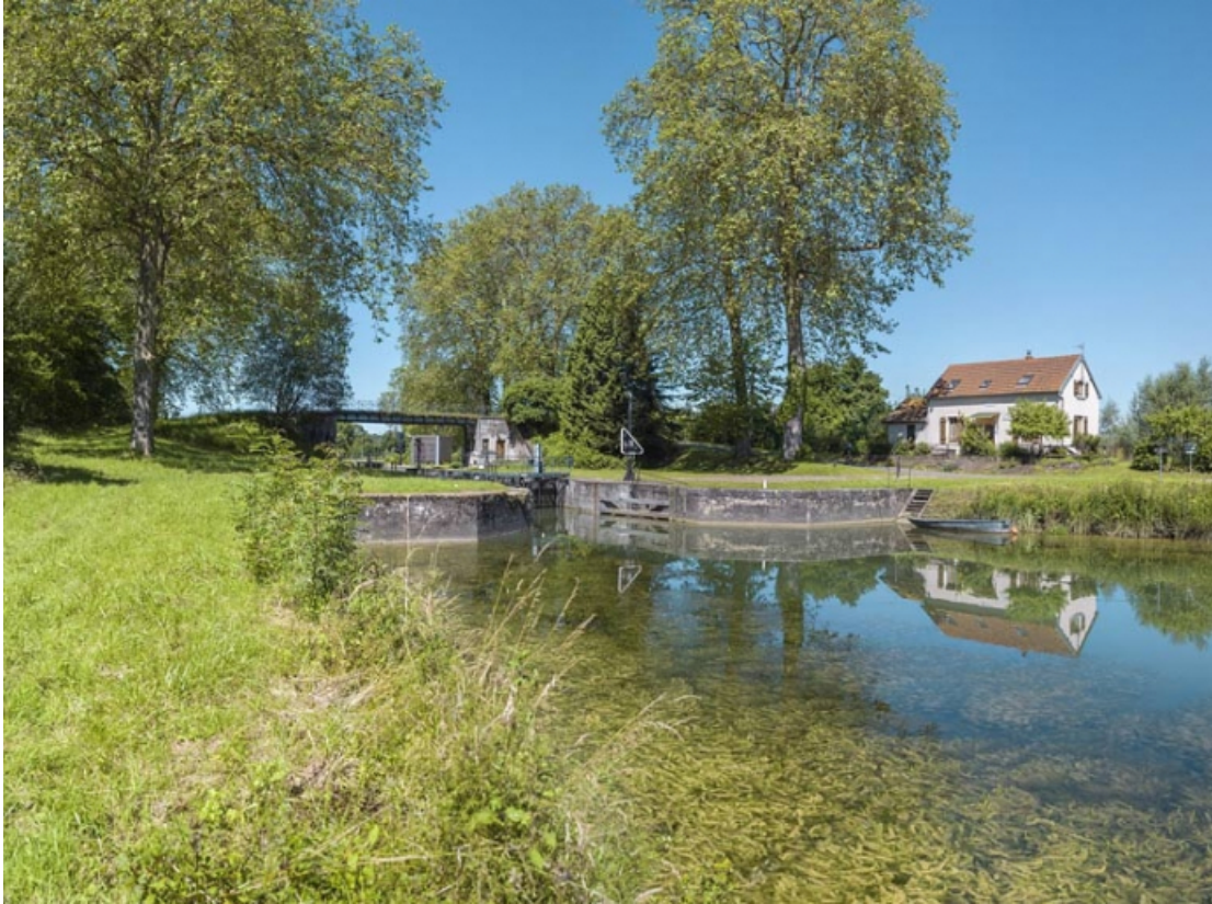
Vue d'amont. Maison éclusière à droite.
