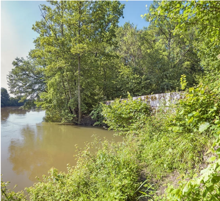
Le pont, vu depuis la Saône.
