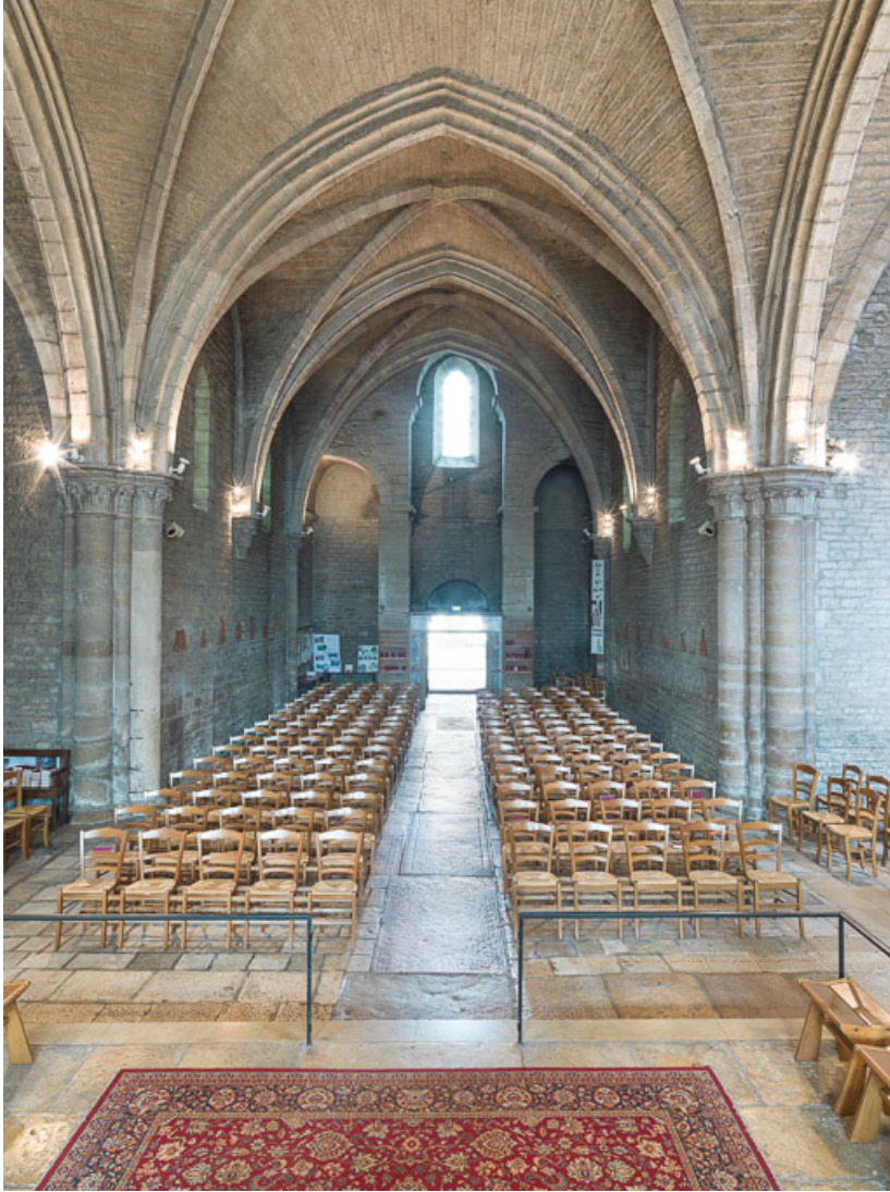
Vue de la nef, vers l'entrée.
