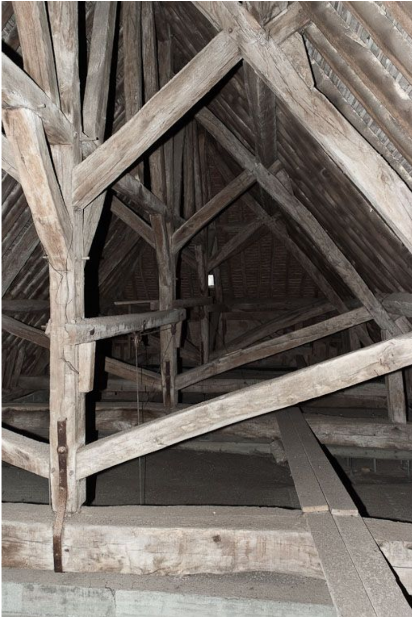
Partie du comble vers la façade.
