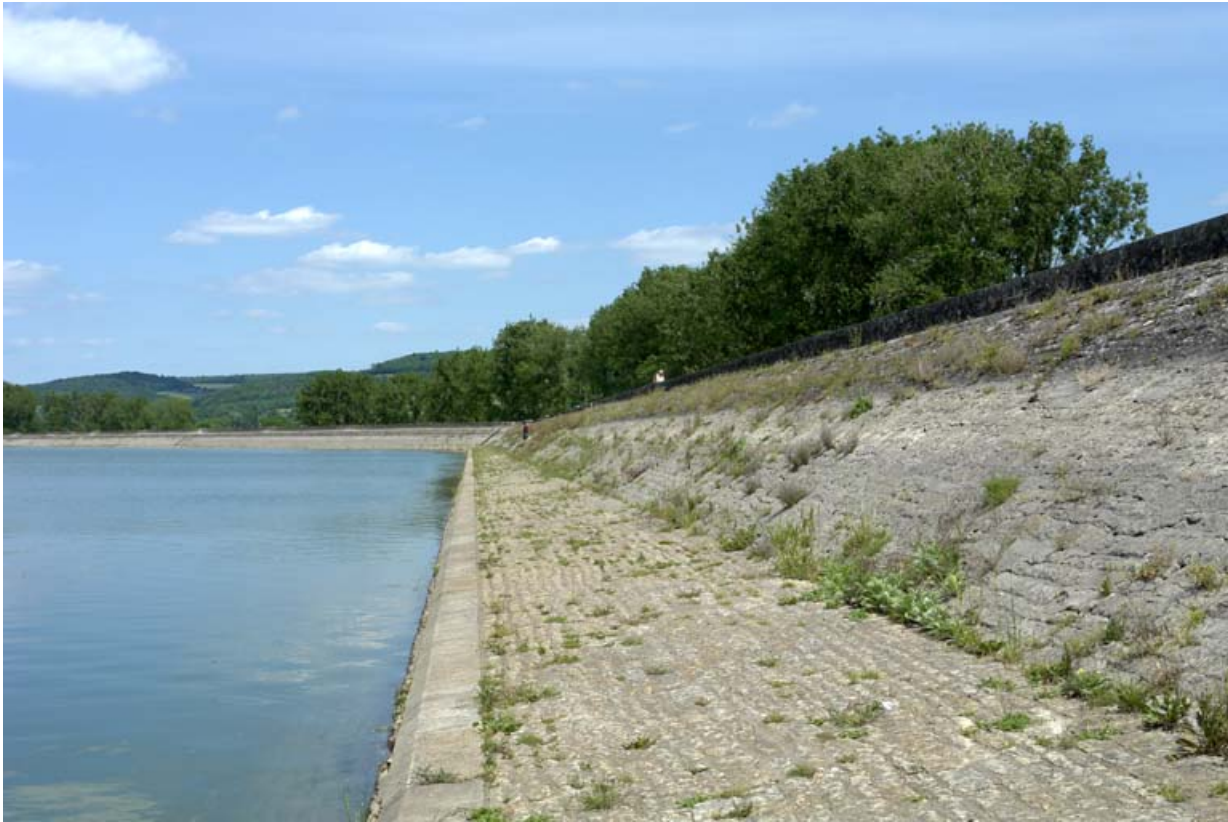
Digue est, vue d'ensemble.
