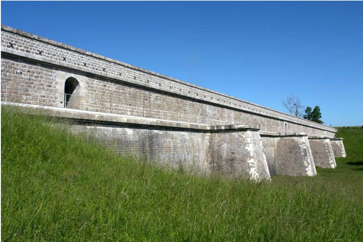
Face avant du barrage, vue d'ensemble.
