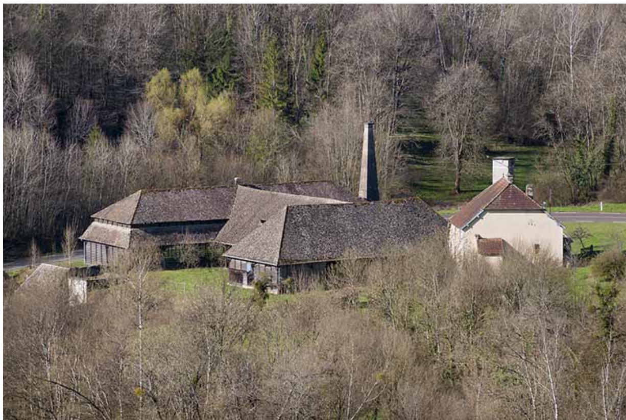
Vue plongeante depuis le nord-est.
