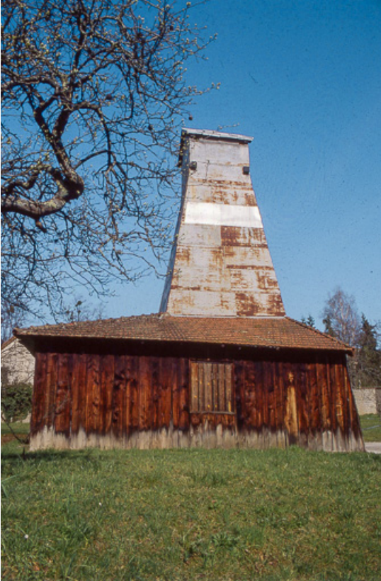
Puits de sondage nord : vue de côté.
