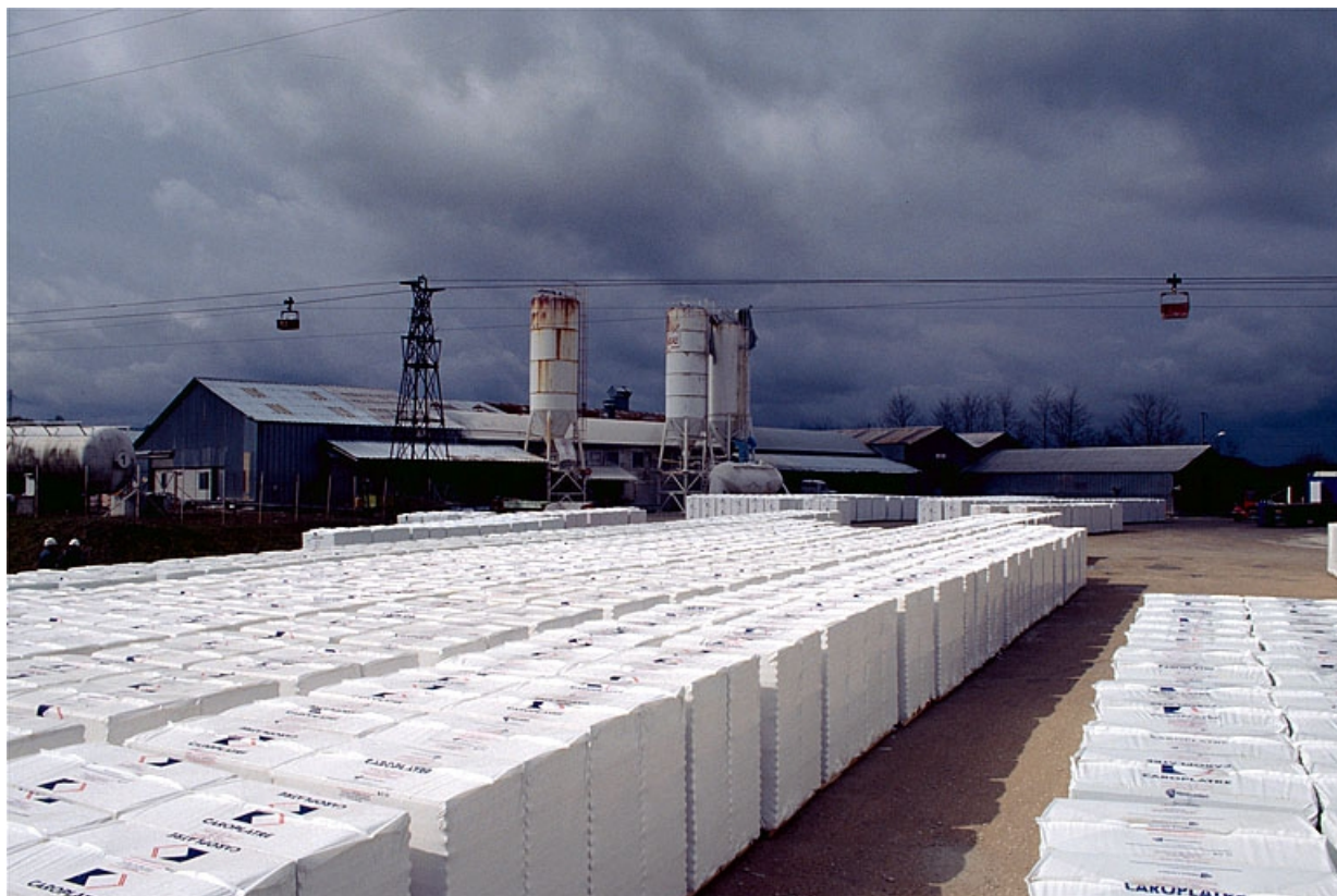
Vue d'ensemble depuis l'est (partie sud).
