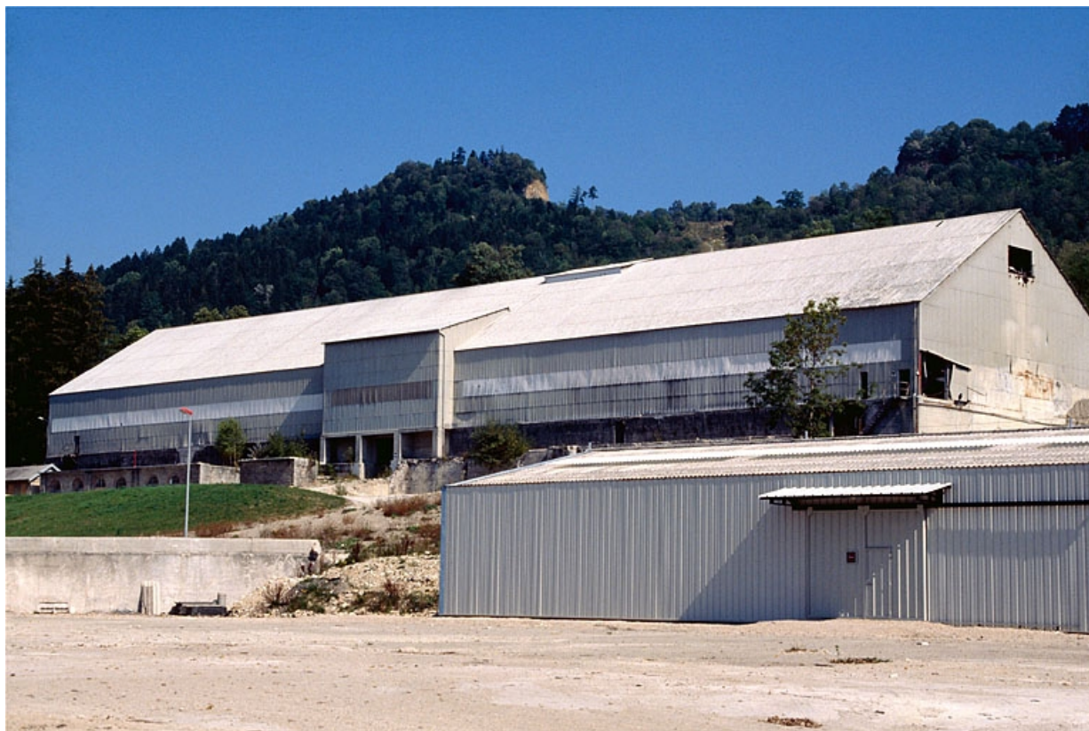
Hall de préhomogénéisation.
