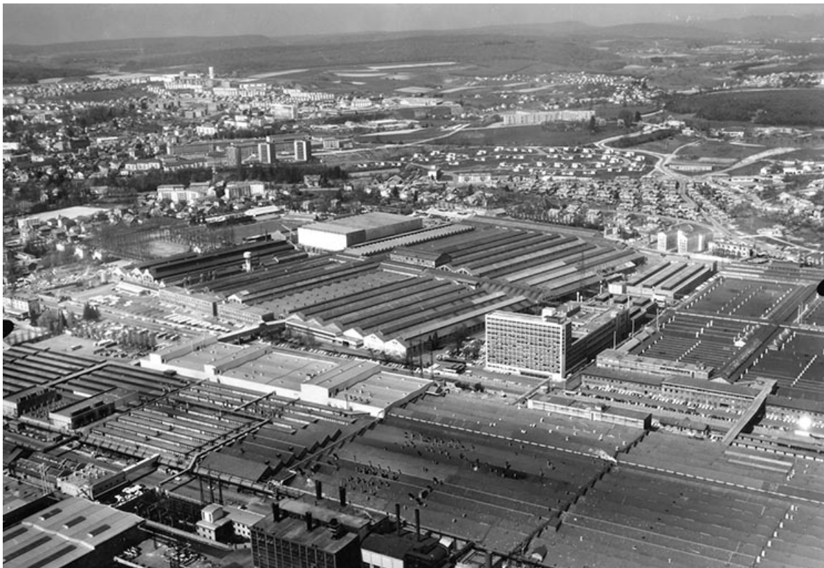
Vue plongeante depuis le sud-est en 1968.
