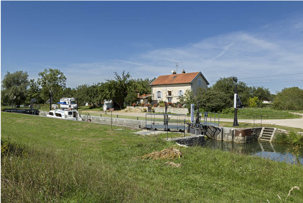
Vue générale du site d'écluse.
