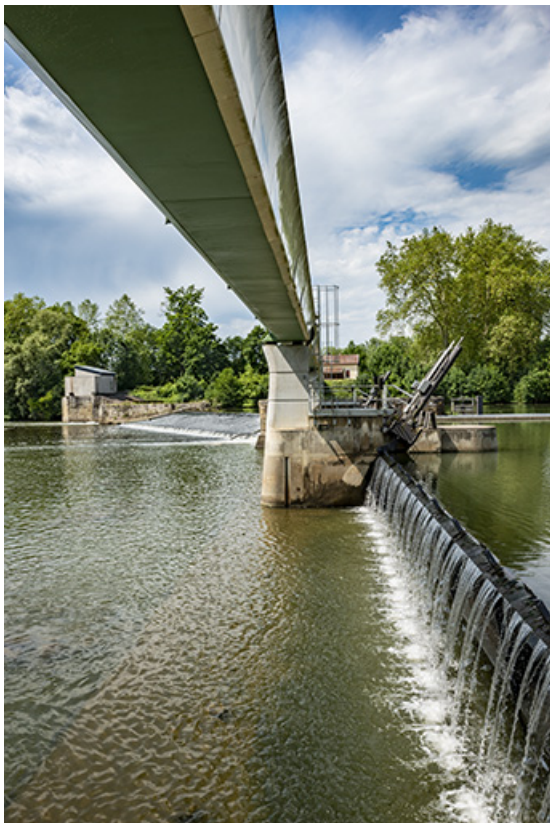
Barrage mobile d'Apremont.
