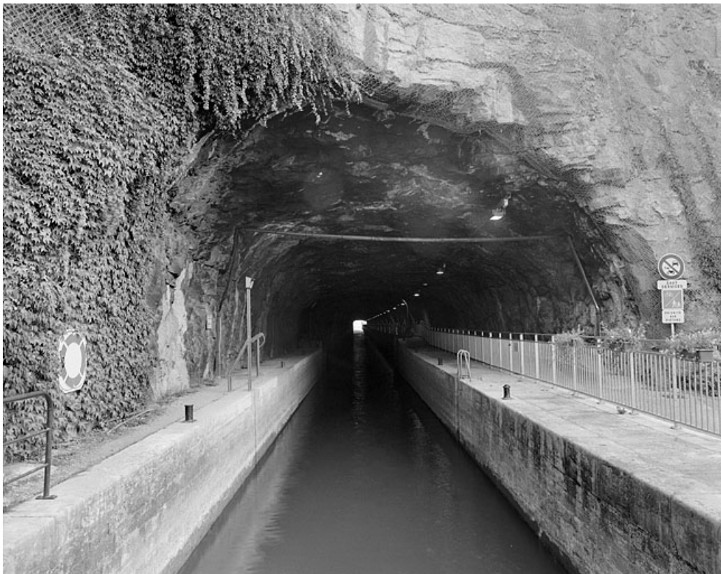
Sas de l'écluse, depuis l'aval.
