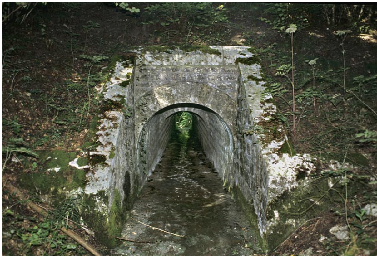
Tête amont (avec éclairage au flash).
