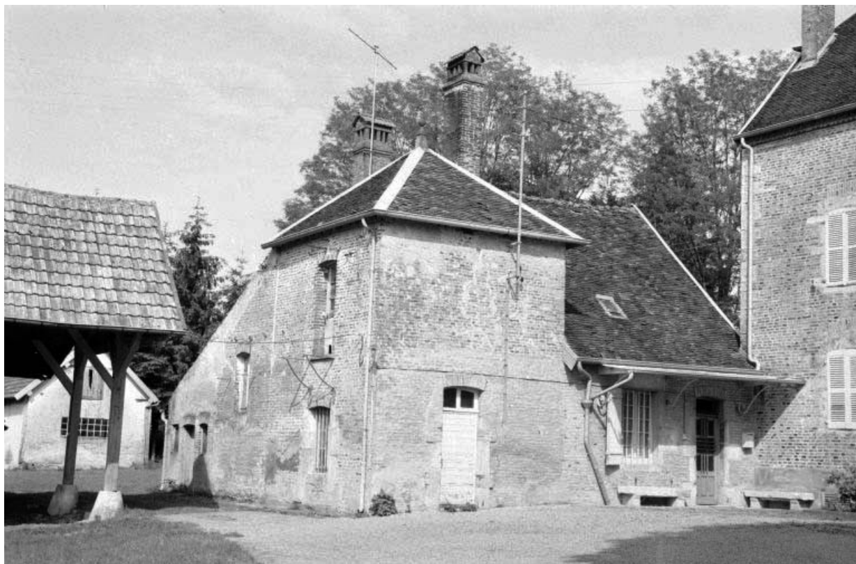
Pavillon nord du logement patronal.
