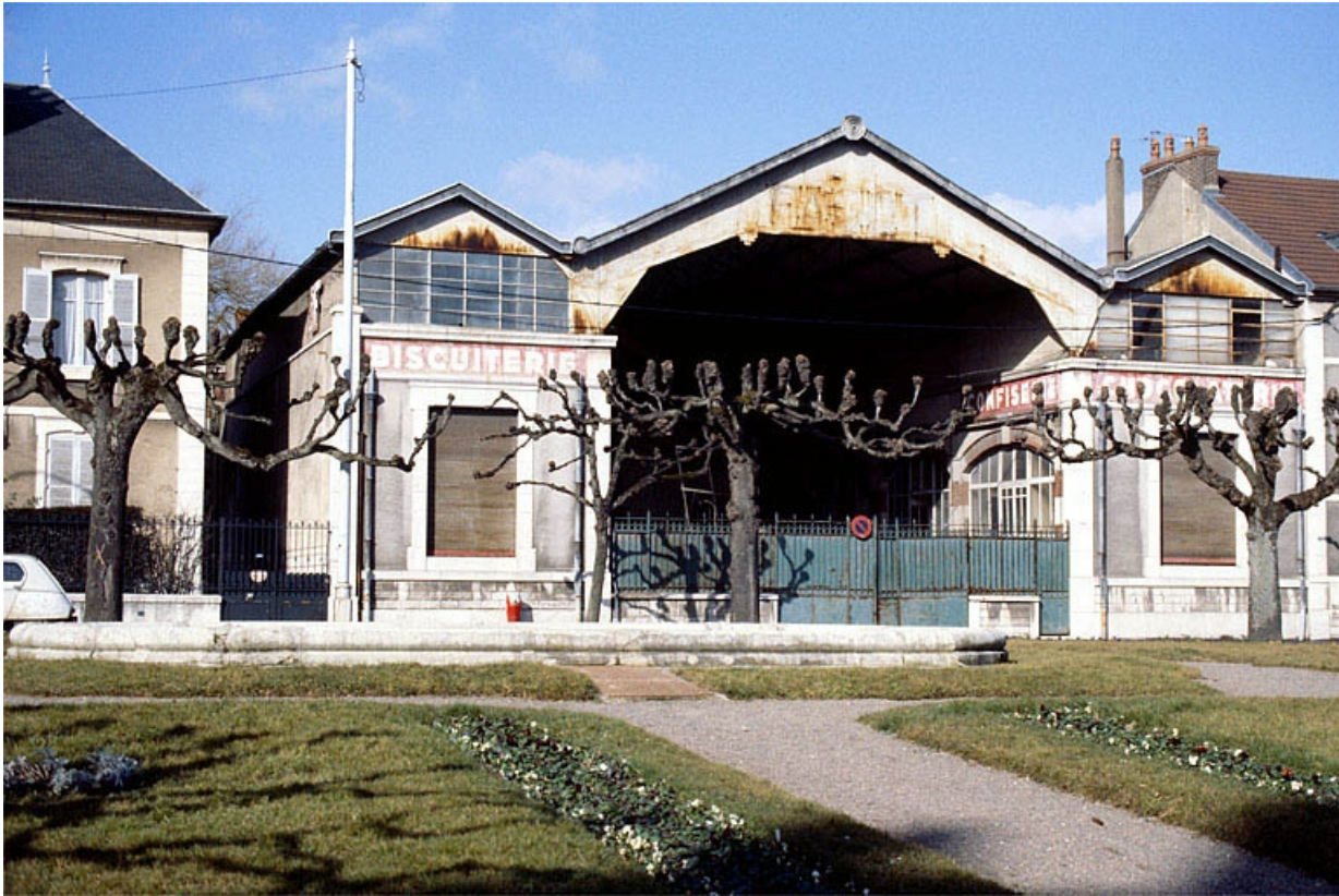
Façade antérieure de l'usine.
