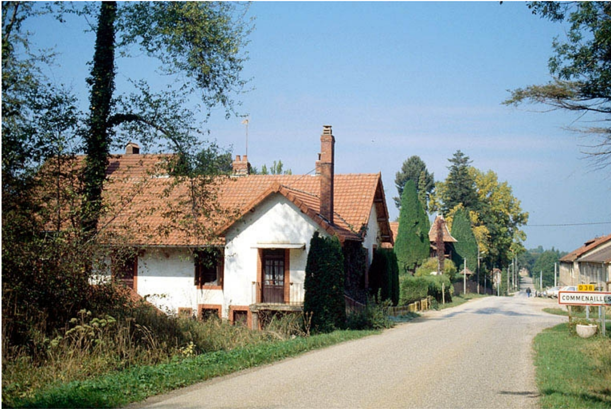
Vue d'ensemble depuis le sud.
