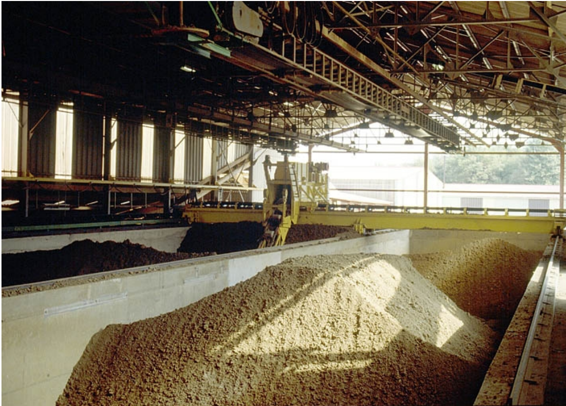
Intérieur du hangar à terre (I).
