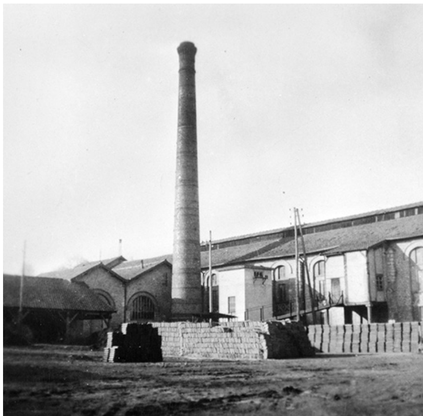
Ateliers et cheminée vus du nord.
