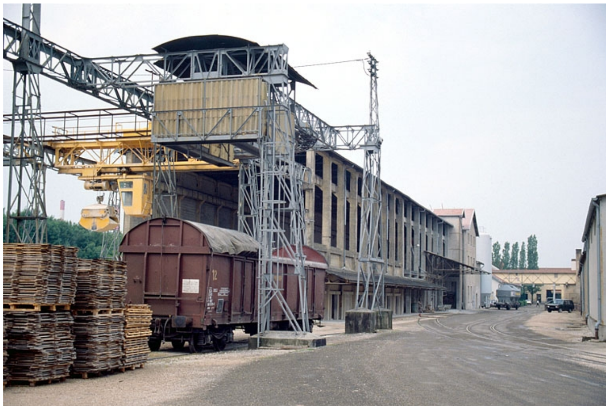
Pont roulant et hangar à terre (18).
