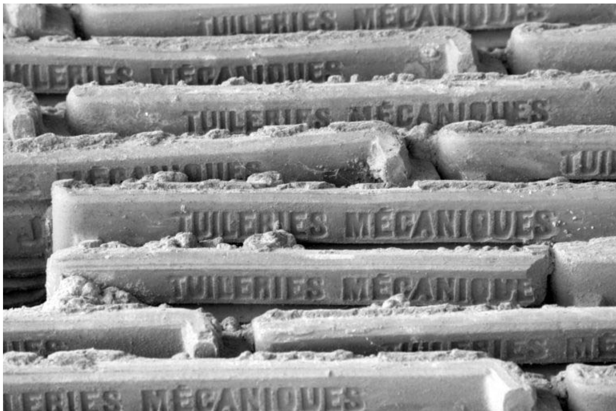
Détail de l'appareil de tuiles en gros-oeuvre.
