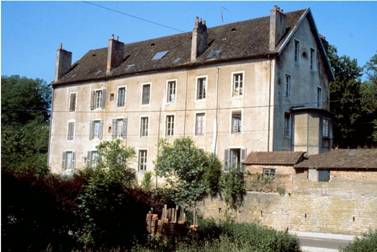
Façade postérieure vue de trois quarts droit.
