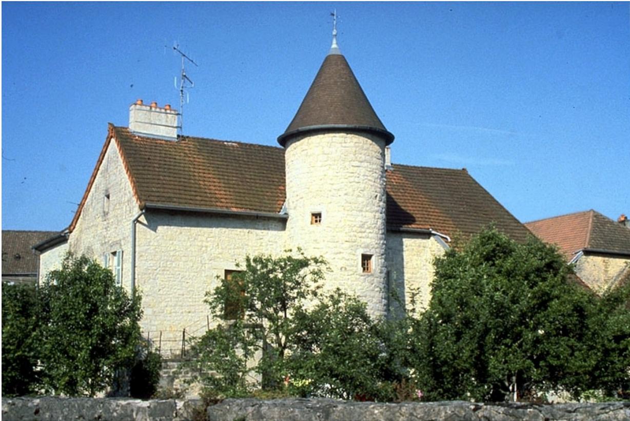
Façade postérieure vue de trois quarts gauche.
