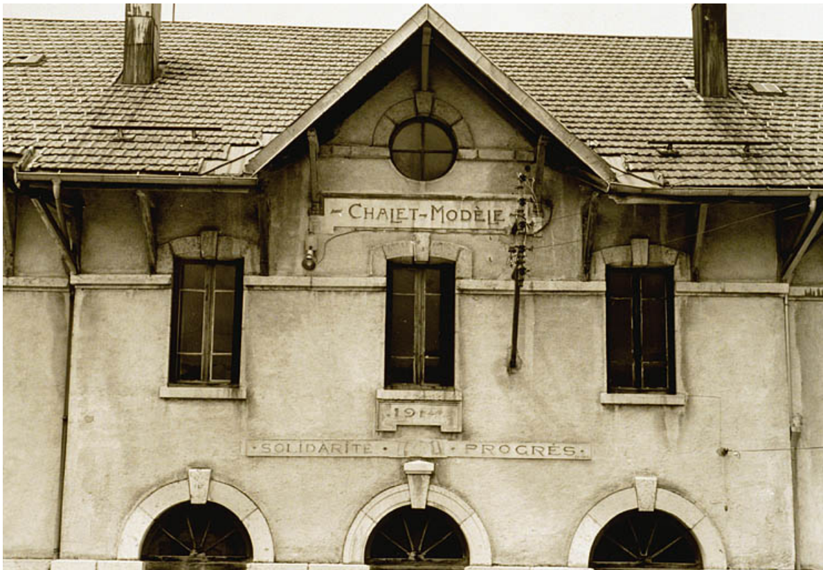
Façade antérieure : partie haute de l'avant-corps central.
