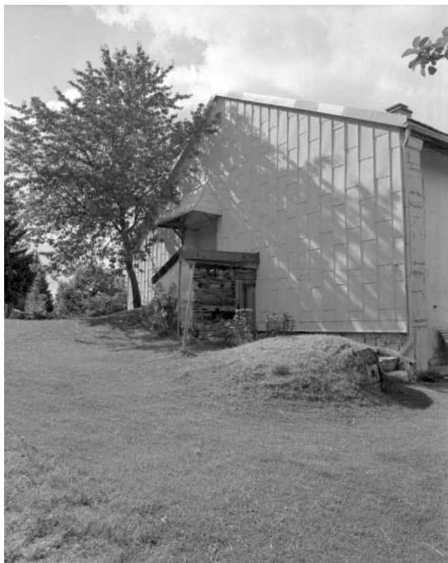
Face gauche recouverte d'un essentage de zinc.
