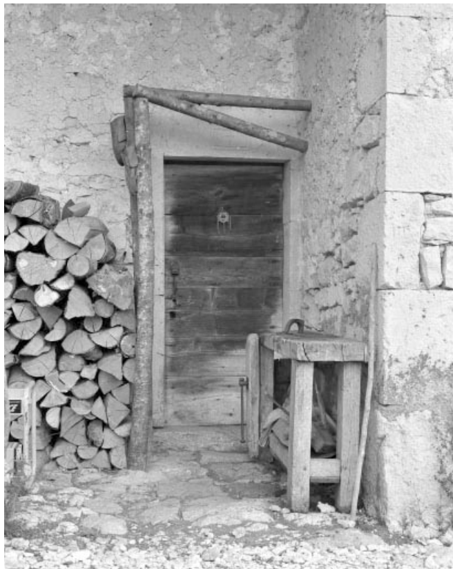
La porte d'accès au logis.
