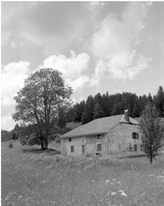
Façade antérieure et face droite.
