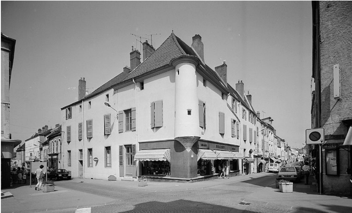
Vue d'ensemble depuis la place Edmond Bour.
