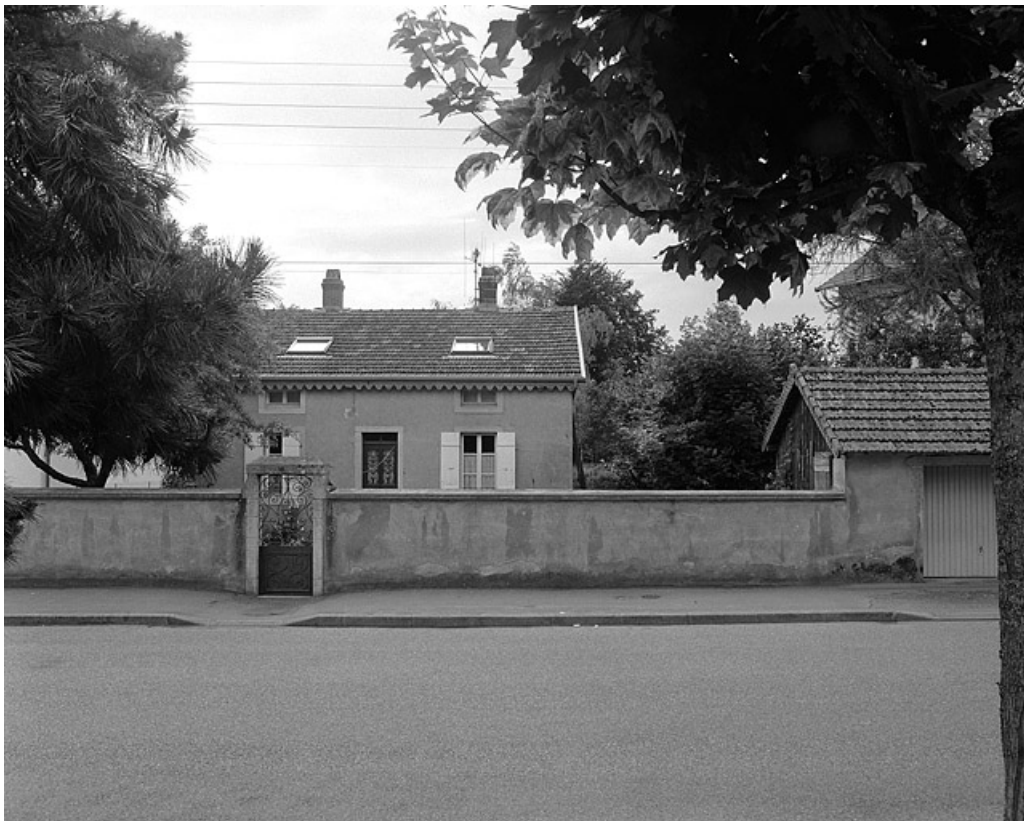
Vue d'ensemble depuis la rue.
