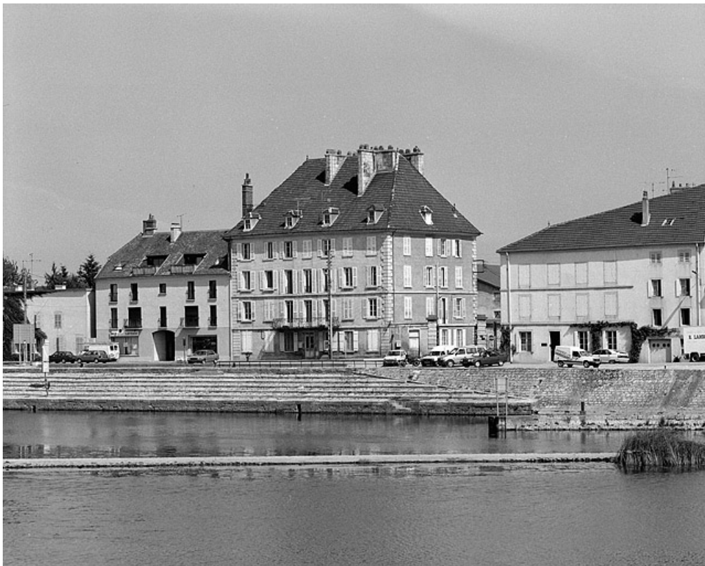
Vue d'ensemble depuis le pont.
