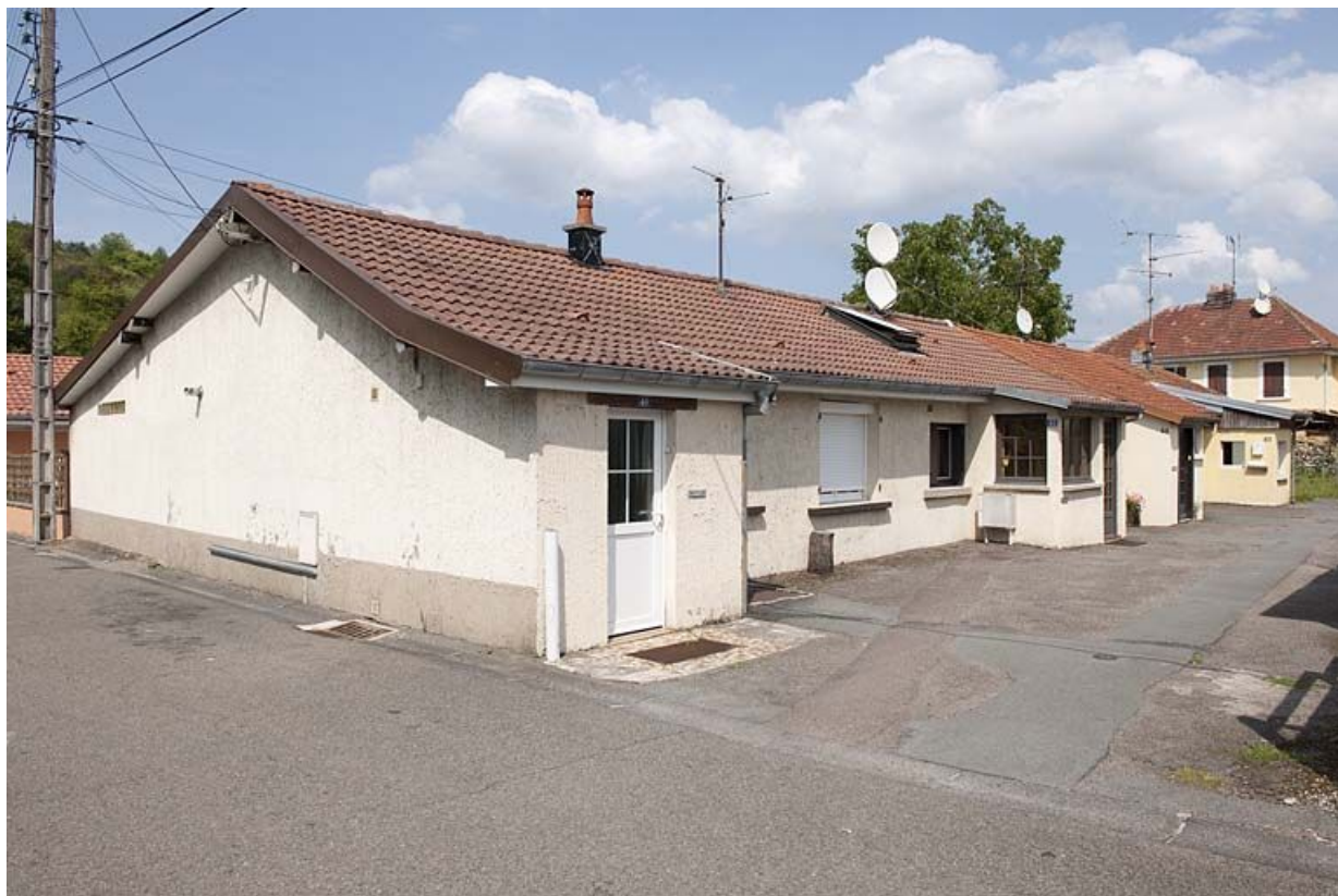
Habitation en rez-de-chaussée. Vue depuis la rue.
