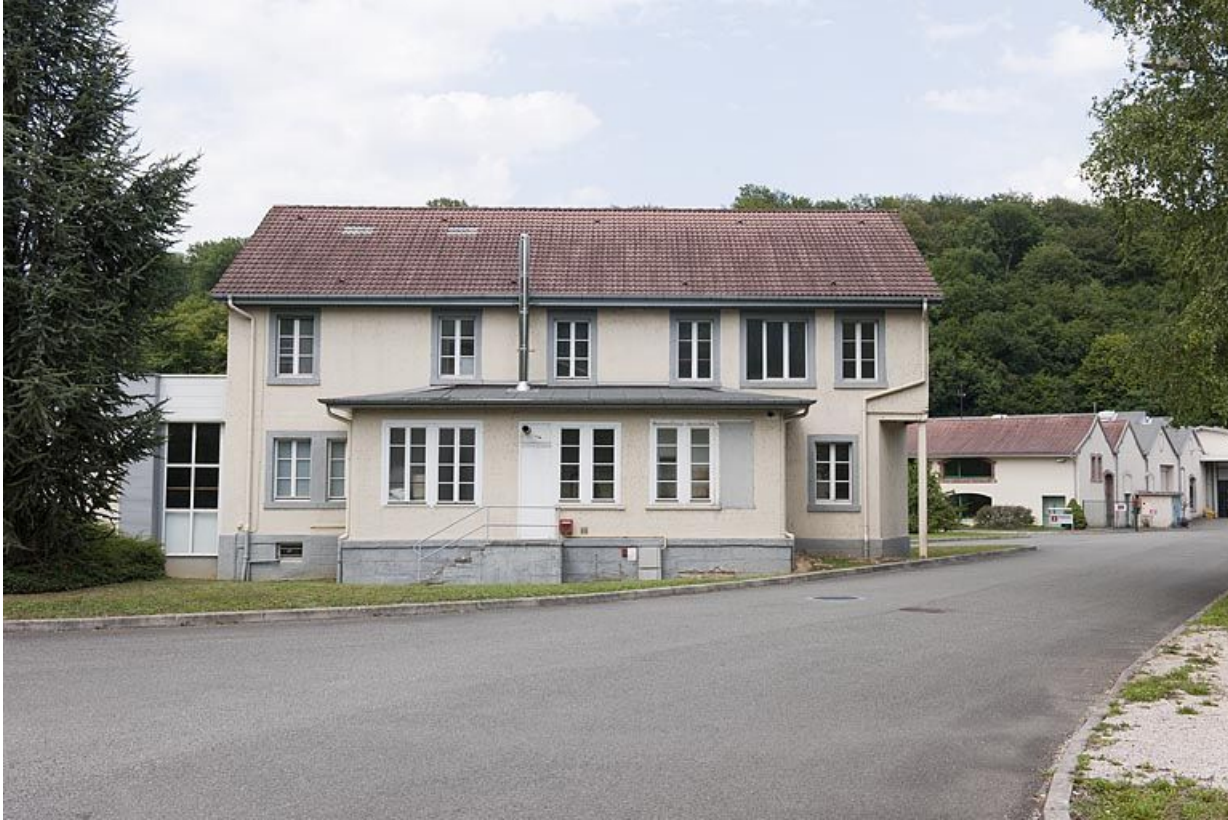
Ancien bâtiment des bureaux. Façade sud.
