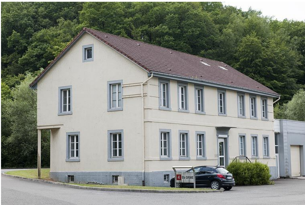
Ancien bâtiment des bureaux. Façade nord.
