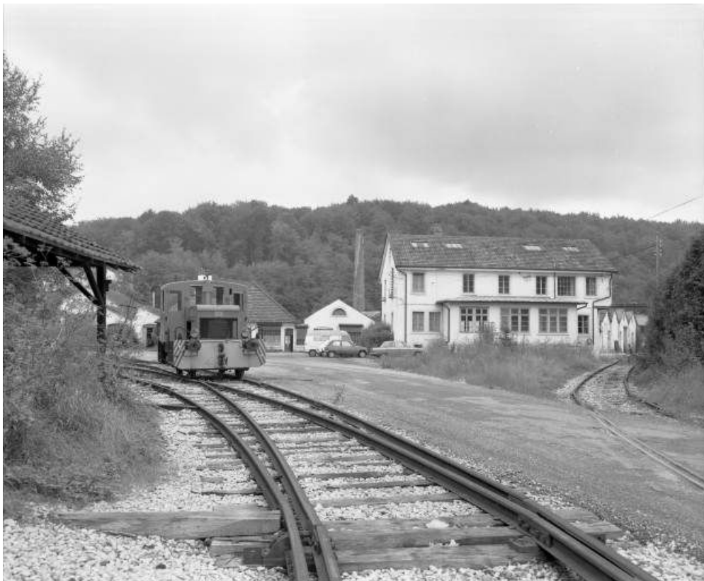
Vue d'ensemble depuis le sud-est en 1981.
