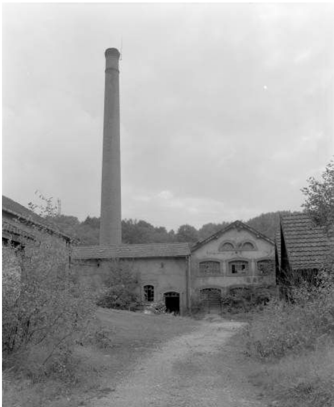
Façade nord de l'atelier de galvanisation en 1981.
