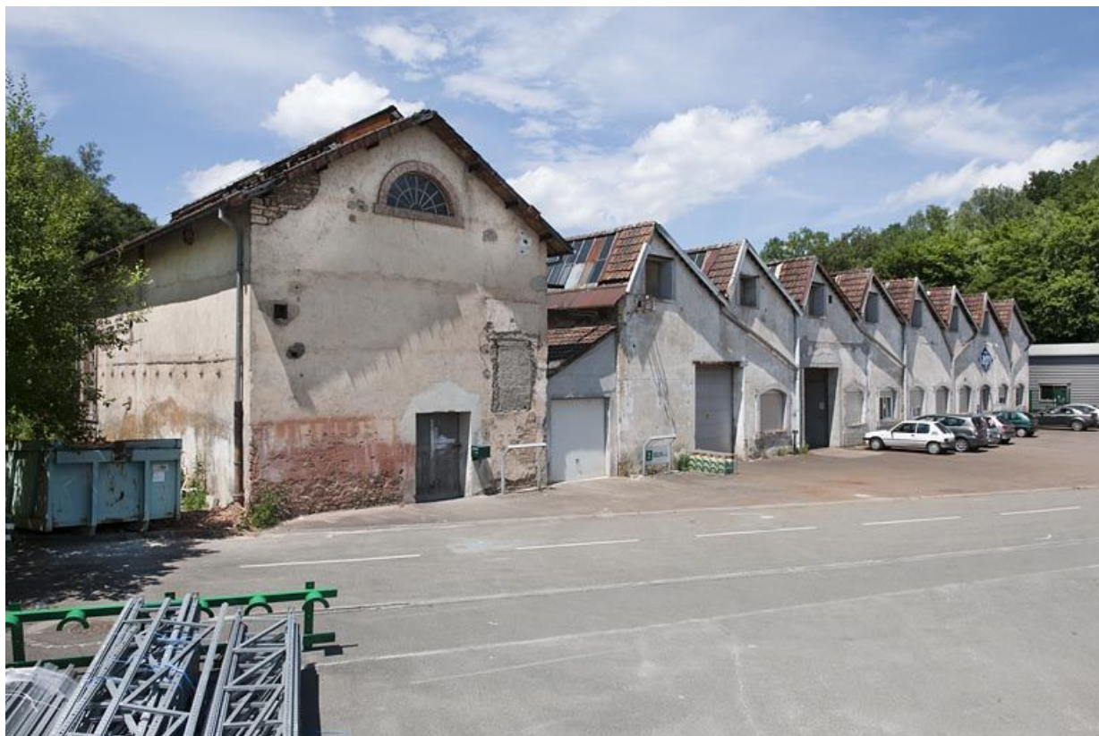
Atelier de fabrication des pompes. Mur-pignons est.
